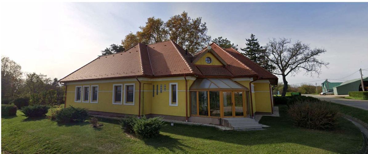
A 01069/4 hrsz. -ú telken lévő irodaépület
